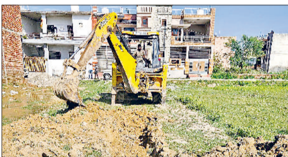
अंबाला। अवैध कॉलोनी में हुए निर्माण दहती जैसीबी।
